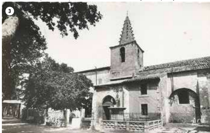
1960 - Carte postale ancienne - L'enclos du presbytère est étendu et encadre l'entrée de l'église et le calvaire; construction de l'escalier béton du presbytère.
